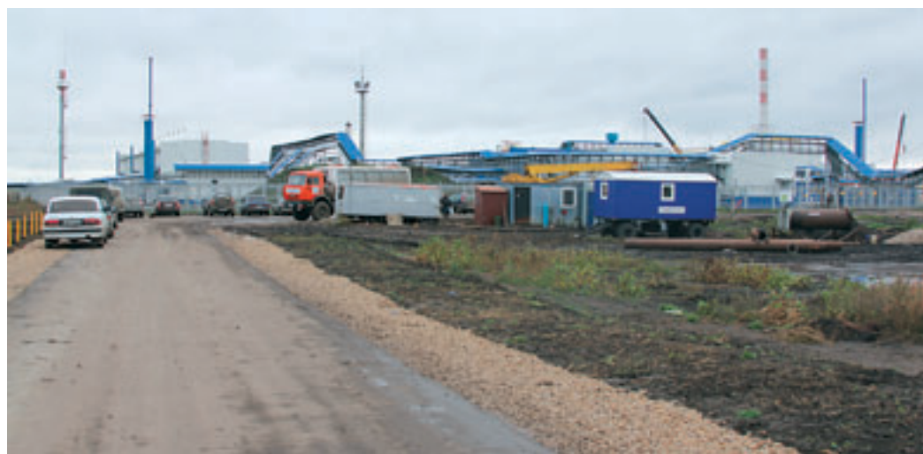
Компрессорная станция № 5 на Степновском ПХГ (фото С. Мильшина).
